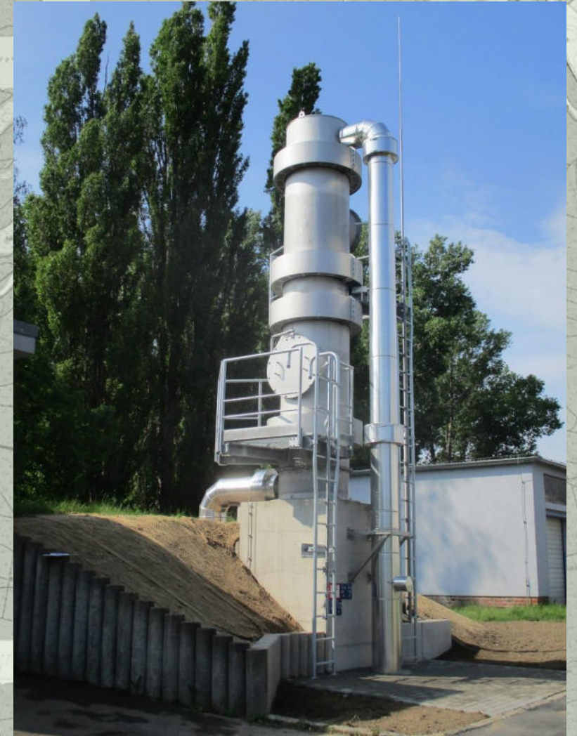
Rohrgitter-Kaskadenbelüfter
