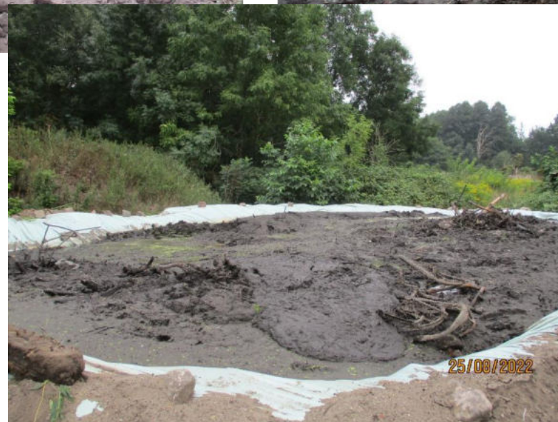
Entwässerung des Aushubmaterials und Störstoffe
